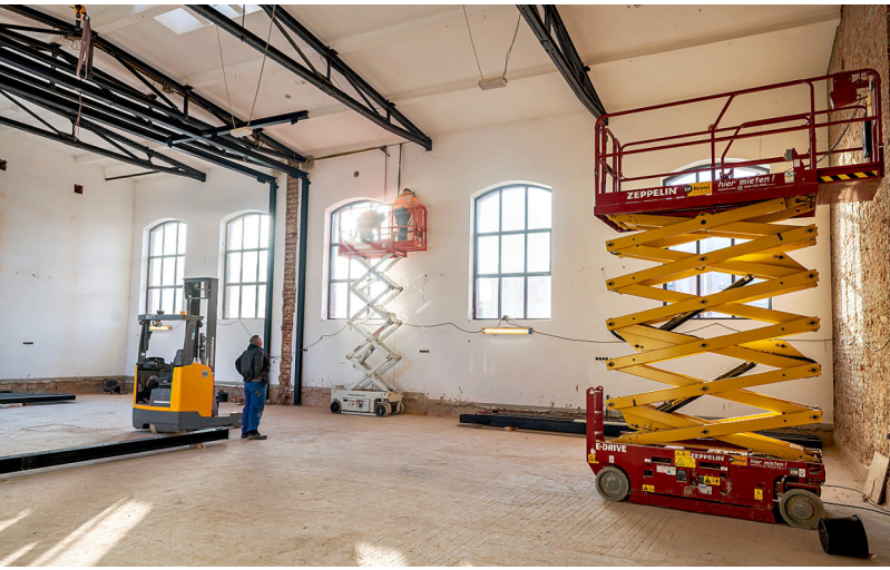
Alte Säulen weg - neue Stahlträger rein. Im zukünftigen Theatersaal, in dem noch eine Arbeitsempore eingezogen wird, haben die Bauarbeiter jede Menge zu tun.
