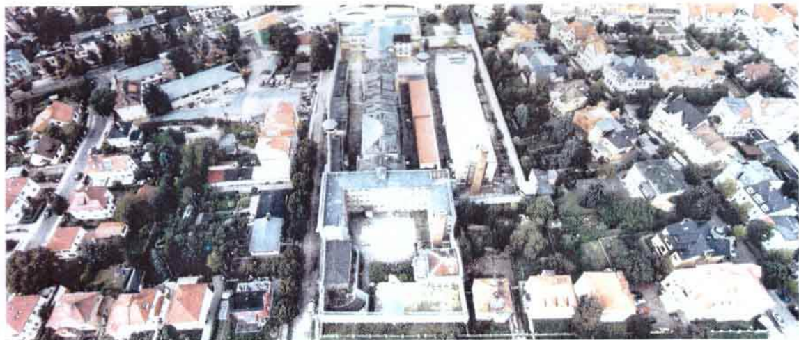
Das Gelände der ehemaligen Justizvollzugsanstalt in Naumburg: Ein Teil könnte für das Theater, ein weiterer Teil für Wohnhäuser genutzt werden.
